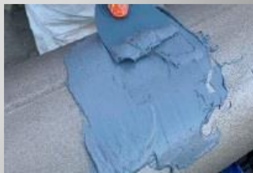
Процес замешивания и нанесения наполнителя
