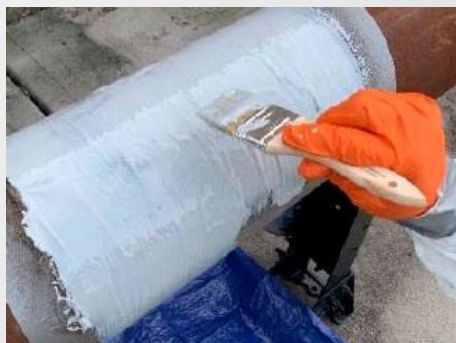
Нанесение грунтовки
