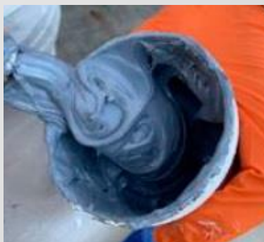
Процес замешивания и нанесения наполнителя
